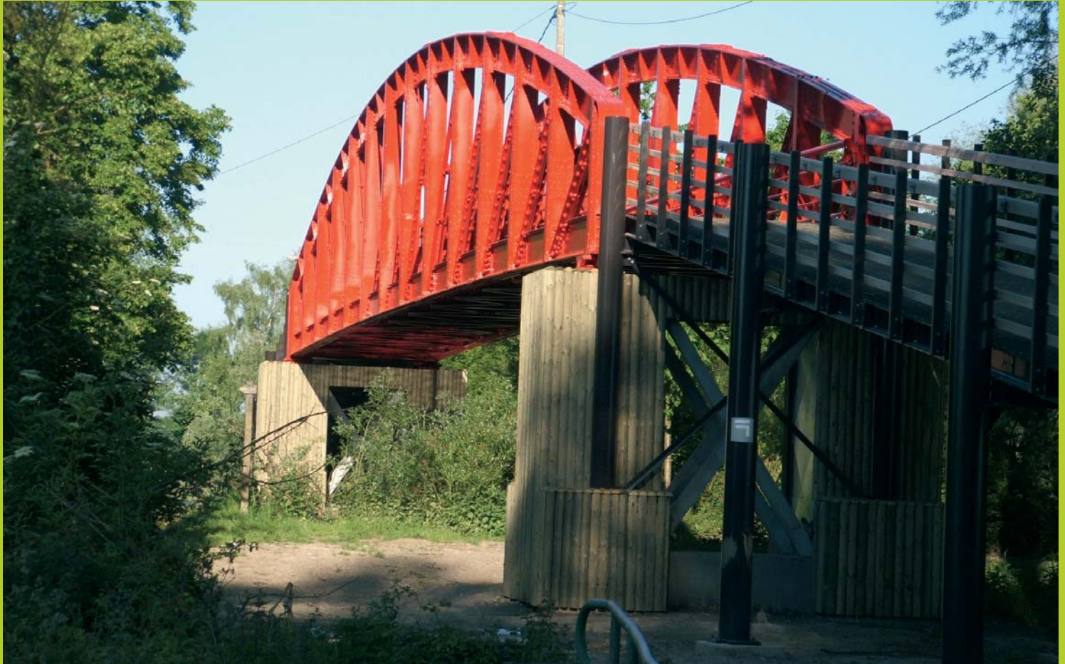
Réhabilitation de la passerelle sur la Vieille Lys
